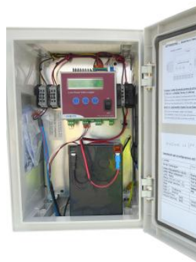
Montaggio nel quadro IP65 per esterni
