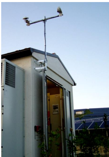
PF2-50 - Palo h=2m con staffe per fissaggio a parete (applicazione tipica per impianti fotovoltaici)
