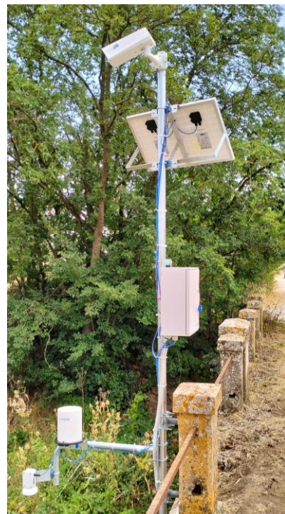
Fotocamera su Stazione meteo-idrometrica con fissaggio a palo
