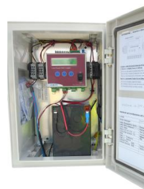
Montaggio nel quadro IP65 per esterni
