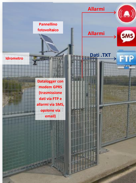
Stazione monitoraggio acque superficiali
