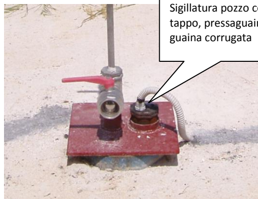
Esempio di installazione in pozzo piezometrico per monitoraggio acque sotterranee
