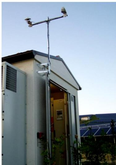
PF2-55 - Palo h=2m con staffe per fissaggio a parete (applicazione tipica per impianti fotovoltaici)
