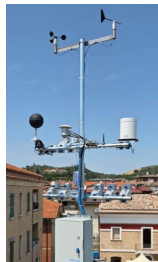
Installazione del pluviometro su palo meteo con sbraccio cod. SBS2D
