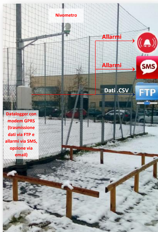
Stazione monitoraggio neve
